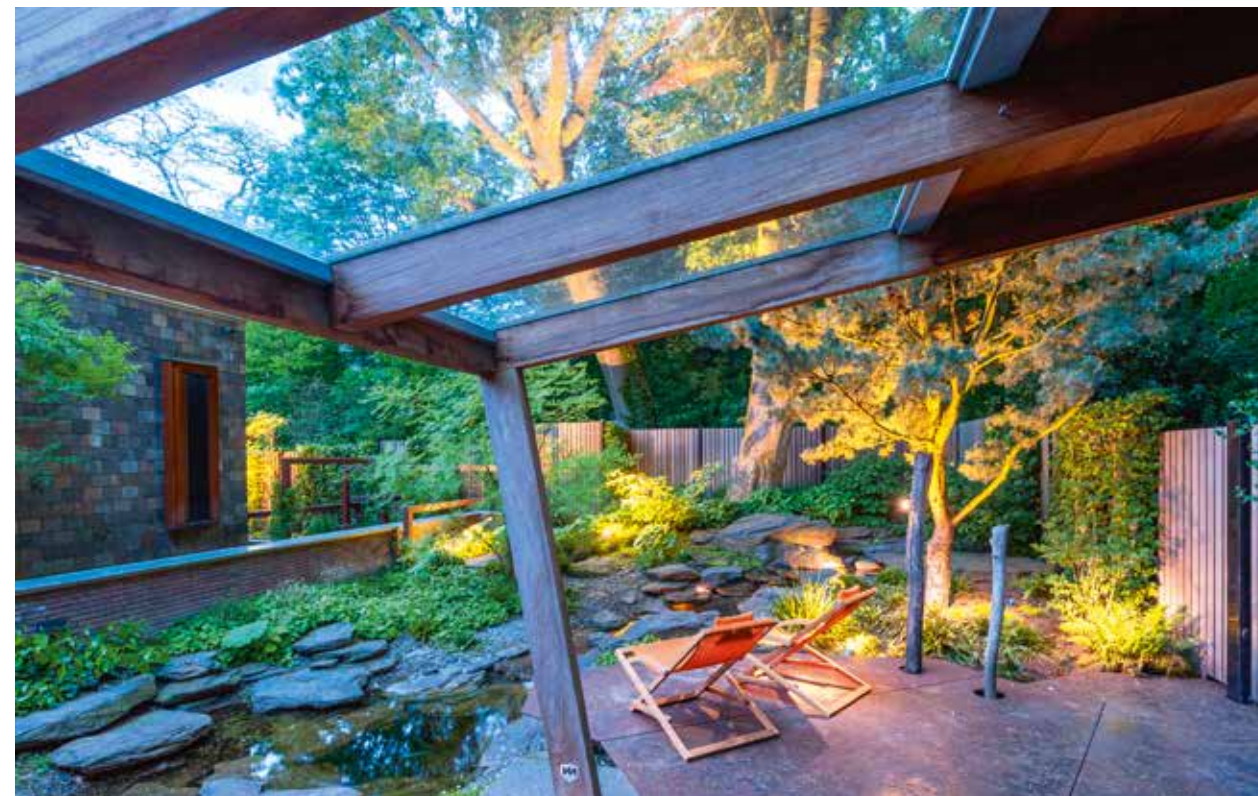
Door een deel van de overkapping van glas te maken zie je hier meer van de groene omgeving. Van Mierlo heeft hem schuin gezet, zodat zich geen vuil ophoopt en het glas bij een regenbuitje schoonspoelt. „En het is een stuk spannender, je moet niet alles voor de hand liggend doen.” De spotjes aan de kromme paaltjes verlichten de routing door de tuin, maar dienen hier ook als leeslampje voor het zitje.
